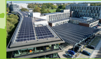
Niederlande EV-Ladepark Eigenverbrauchsoptimierung, Lastspitzenkappung, Ladesäulensteuerung, Prognosebasiertes Laden, Dynamische Stromtarife
